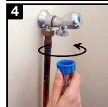
Otvorte kohútik na prívode vody. Skontrolujte, či voda nevyteká tam, kde nemá. Hadicu na prívod vody nemožno predĺžiť. Ak je príliš krátká, kontaktujte popredajný servis.
